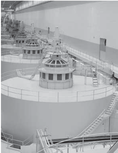
Aplicación de bombeo
