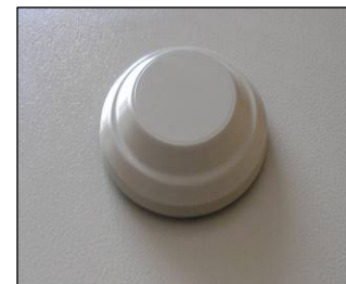
Sortie Azote Purge (haut de l'armoire)
