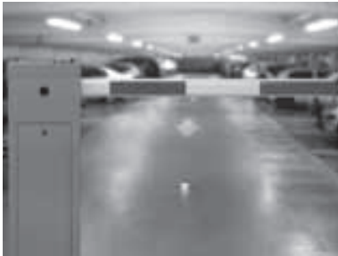
Steuerung einer Zugangsschranke mit ATV 12
